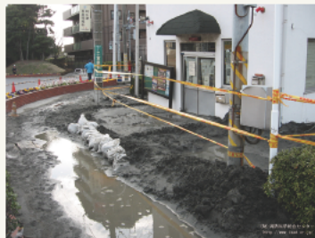
東日本大震災での液状化被害 (一財)消防防災科学センター
