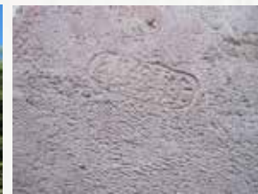
煉瓦土蔵の周辺で発見された煉瓦。「上敷免製」の刻印があり、日本煉瓦製造株式会社の煉瓦であることがわかります。
