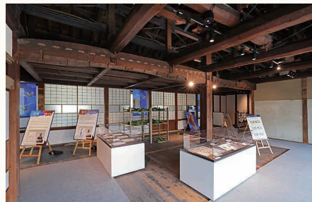
耐震補強の様子がみられる2階
