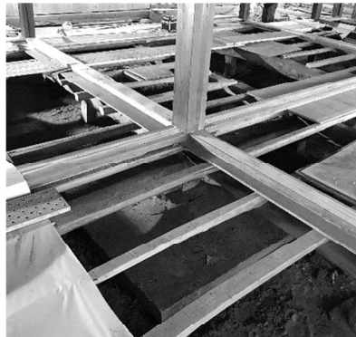
写真 5.6.6 中黒柱独立礎石基礎補強完了
