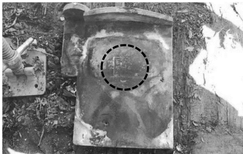
写真 5. 4. 9 瓦の刻印その1の1 瓦裏面に刻印(写真○印)
