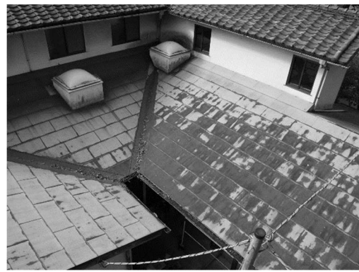
写真 5.4.14 北側下屋 北中央・北西部分
