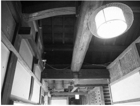
写真 5.5.37 蚕室より廊下5を見る 改修前
