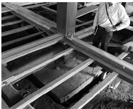
写真 5.6.5 大黒柱独立礎石基礎補強完了
