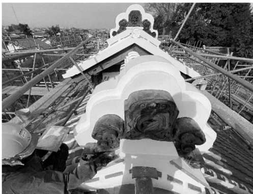
写真 5.7.7 ⑭仕上塗り
