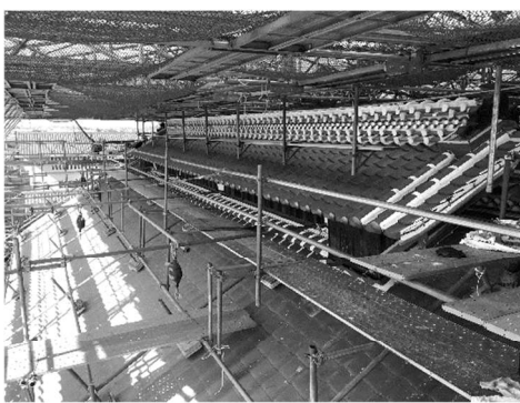
写真 5.4.22 瓦葺完了
