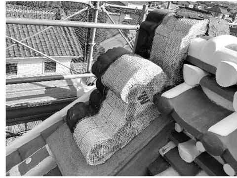
写真 5.7.4 ⑨影盛 ラス貼り
