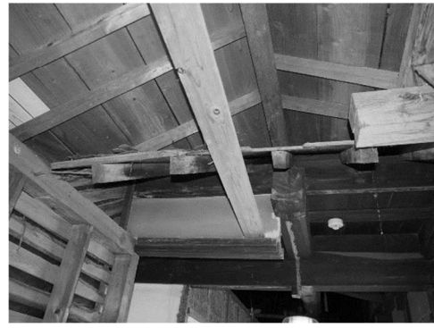
写真 5.5.38 廊下5天井 改修前
