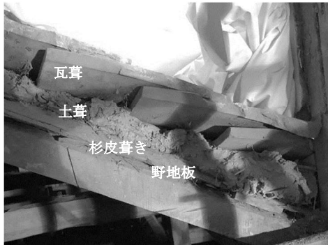
写真 5.4.17 改修前 棧瓦・下地断面
