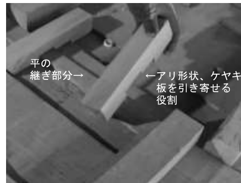
写真 5.5.26 式台背面 平部分の固定
