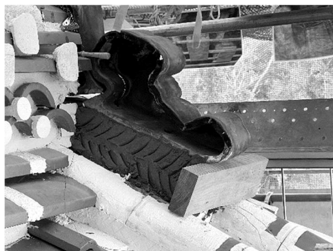
写真 5.7.1 ④鬼瓦台 下塗り
