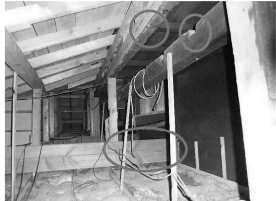
写真 5.5.2 北側下屋 小屋裏
