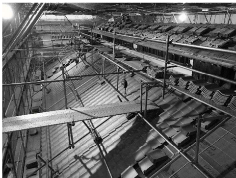
写真 5.4.21 平瓦葺き
