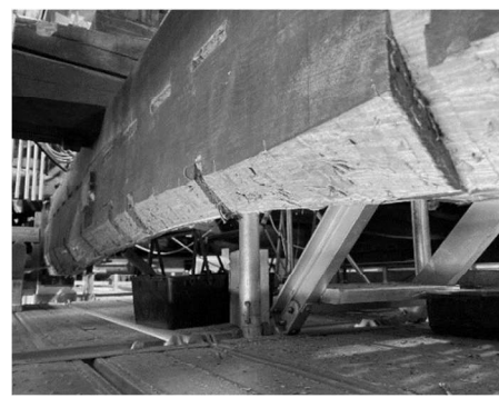
写真 5.5.16 敷梁 天井下地・棧棚の痕跡
