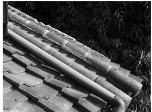
写真 5. 4. 6 主屋下屋部分南ケラバ
