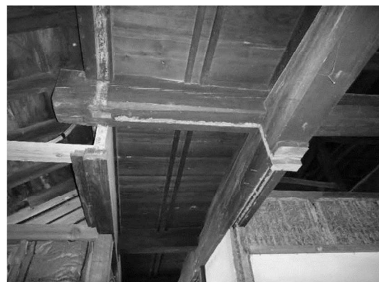
写真 5.5.4 2階広縁2、廊下5 上部
