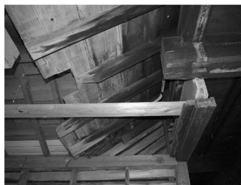
写真 5.5.36 広縁2 17通-ぬ通 改修前2
