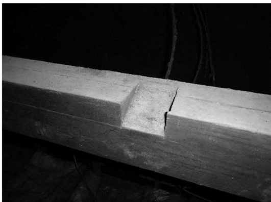
写真 5.5.3 北側下屋 小屋裏 旧桁材
