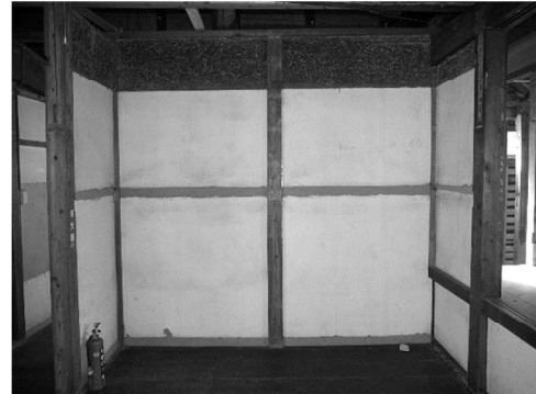
写真 5.5.14 2階蚕室 間仕切り壁 17 通北
