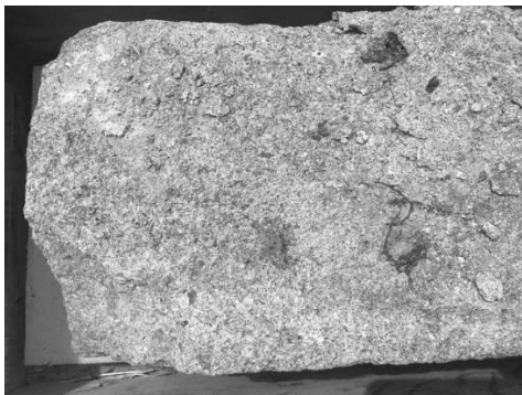
写真 5.6.1 ドマ 礎石 表面風化の様子
