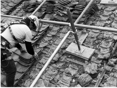
写真 5.4.15 改修前 手払しによる瓦取外し
