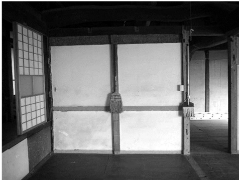
写真 5.5.13 2階蚕室 間仕切り壁 5 通北
