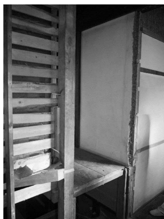
写真 5.5.35 広縁2 17通-ぬ通 改修前1
