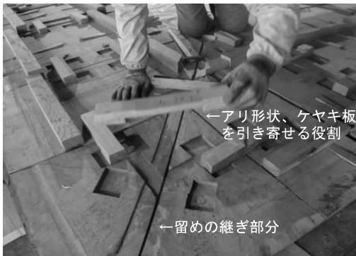
写真 5.5.25 式台背面 留め部分の固定
