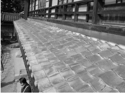
写真 5. 4. 3 主屋下屋部分南東部分
