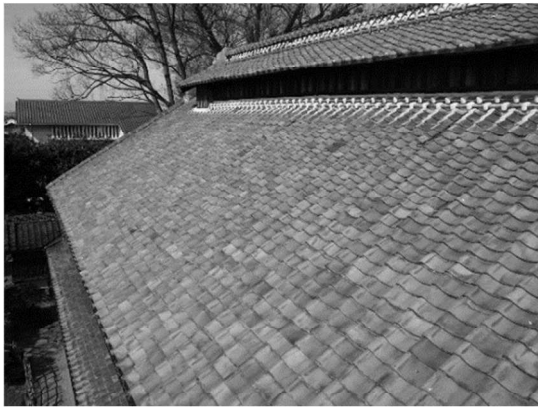
写真 5.4.1 主屋 2 階部分南東部分
