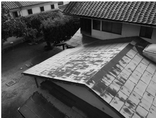
写真 5.4.13 北側下屋 北東部分全体
