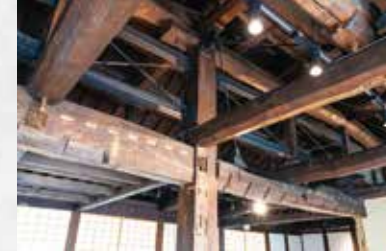
大黒柱周りの耐震補強の様子
