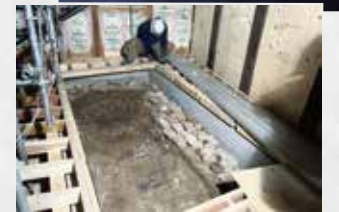
確認された煉瓦製カマド跡を保存
