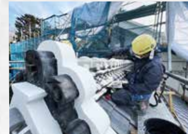
屋根化粧漆喰施工
