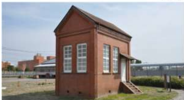
旧製電室 外観
