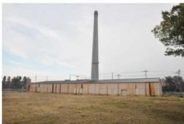
ホフマン焼窯4号窯 外観
