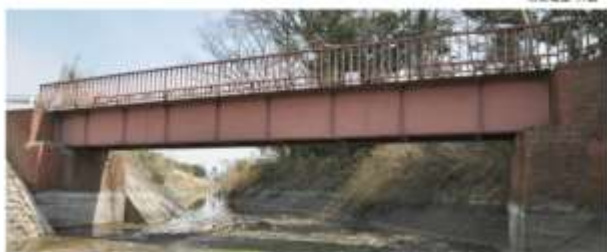
備前東鉄橋 上流側
