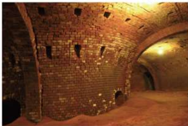
ホフマン焼窯4号窯 焼成室内部
