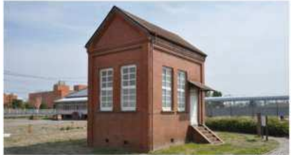
旧発電室 外観
