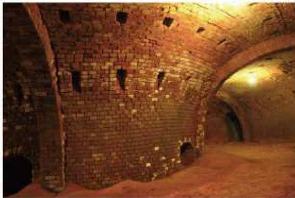
ホフマン輪窯4号窯 窯内観
