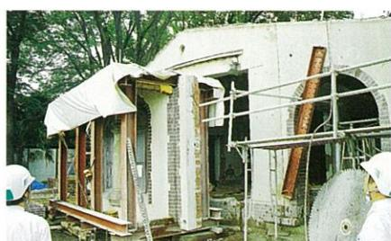
切断され取り外された出窓（解体工事）
