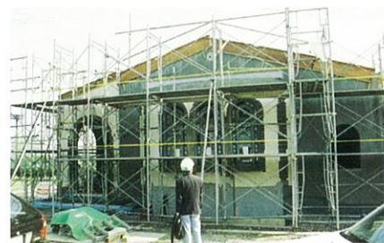
移設されたベランダ及び出窓と新規再現された外壁
