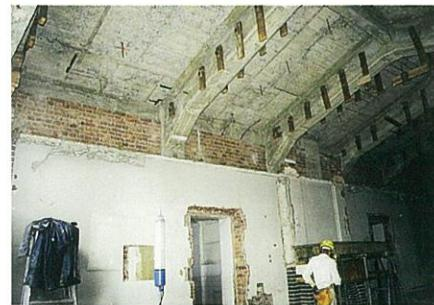
解体中の清風亭の内部。煉瓦がコンクリートの補完材として使用されている様子がわかる。
