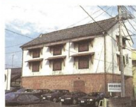
やなぎはなものでん ■旧柳瀬金物店倉庫 (深谷町9)
