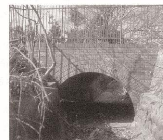
煉瓦アーチ橋
