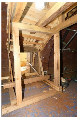
作業用型枠の設置
