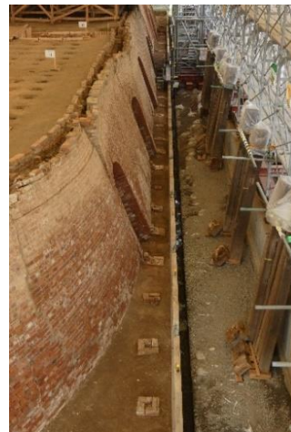
木造覆屋柱解体後
