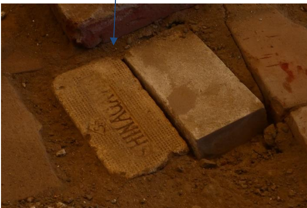
窯の外側に敷かれた煉瓦と 品川白煉瓦株式会社製の耐火煉瓦
