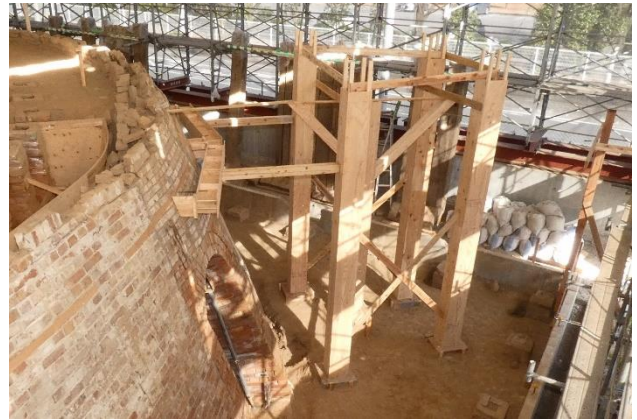
窯補強部材の検討
