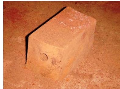
暗渠側面に使用されていた有孔煉瓦
