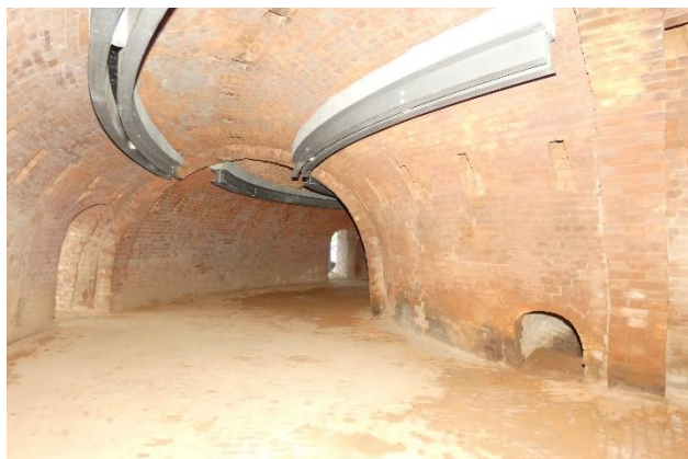
保存修理工事竣工写真
