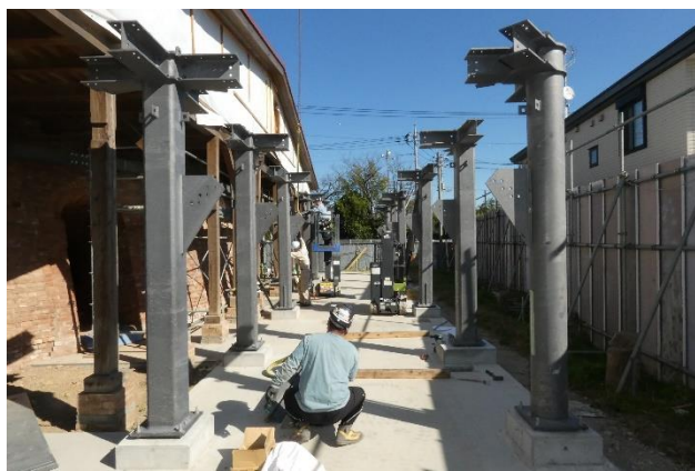
鉄骨補強材の組み立て
