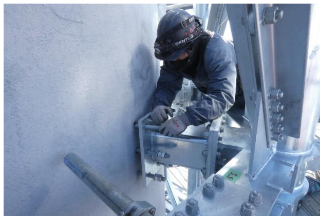
鉄骨補強と煙突の連結
