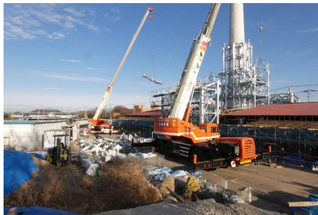
煙突部鉄骨補強の組み立て
