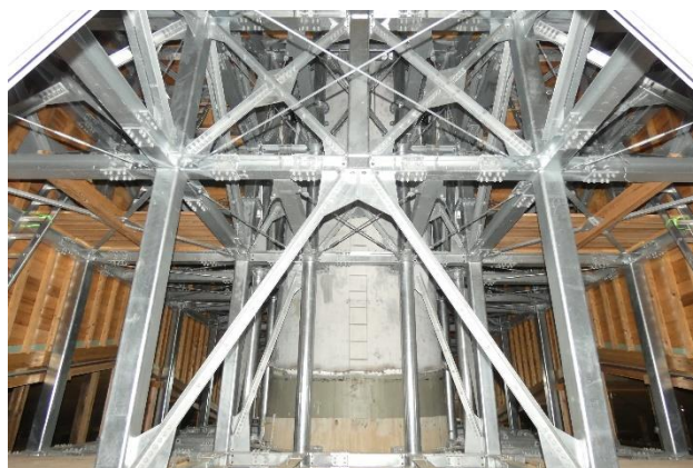
煙突部鉄骨補強空間の内部
