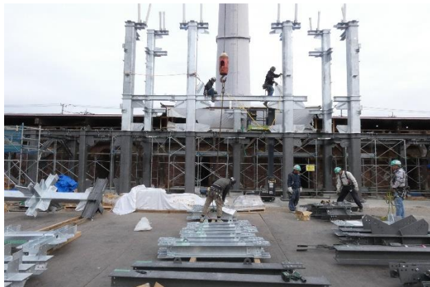
煙突部鉄骨補強の組み立て
