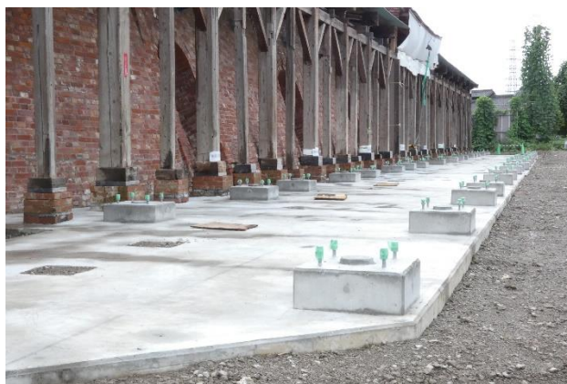
鉄骨補強材の基礎
