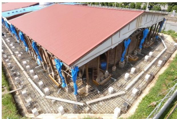
コンクリート打設のための配筋
