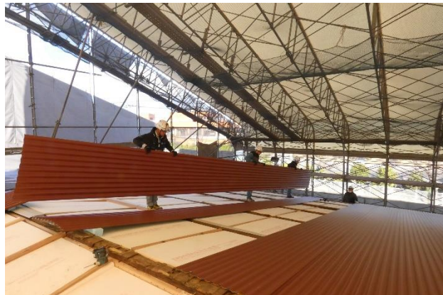
波板屋根の設置
