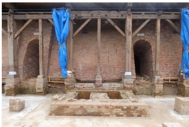
発見されたエレベーターの基礎
