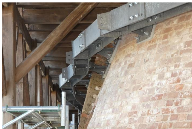
窯壁鉄骨の設置
