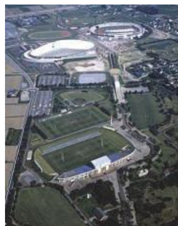
県営熊谷スポーツ文化公園
