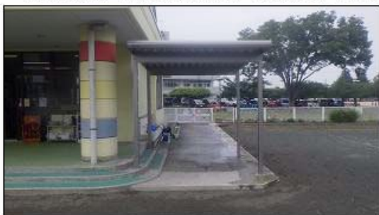
深谷西幼稚園側給食運搬車両受け入れ部の庇設置
