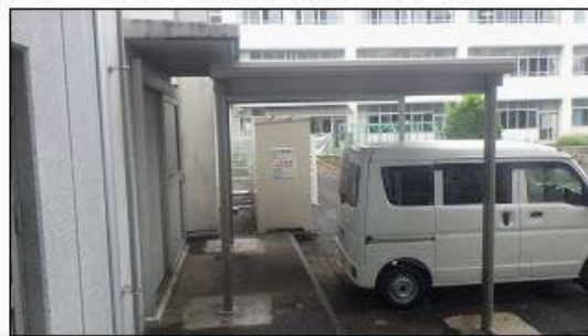
深谷西小学校給食場側の庇設置
