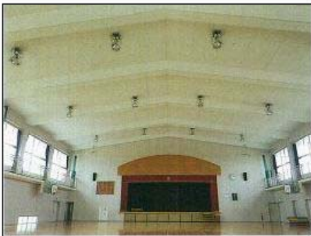
大寄小学校 体育館(改修前)
