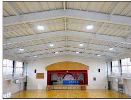
大寄小学校 体育館(完成)
