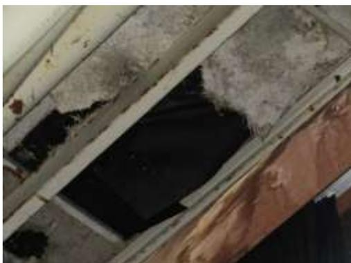
No.2 雨漏りの影響による天井建材の腐食
