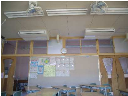
普通教室のエアコン整備
