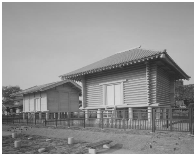
2 号建物（奥） 1 号建物（手前）
