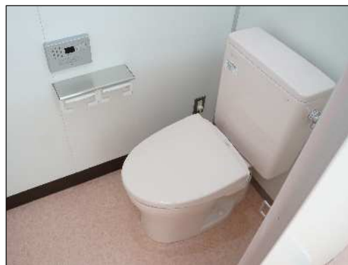
(改修後) トイレ洋式化
