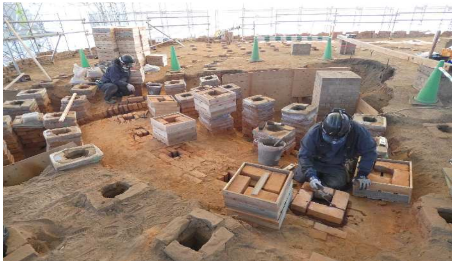
ホフマン輪窯6号窯保存修理工事
