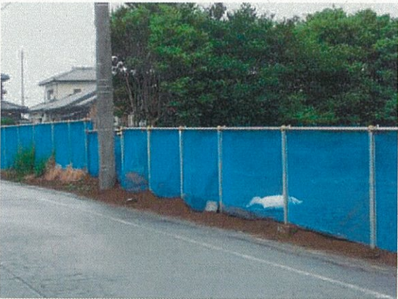
防風ネットを設置した様子 (宿根地内)
