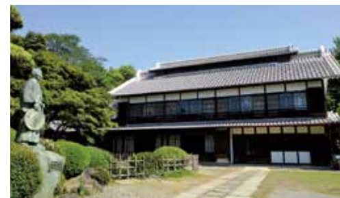
耐震改修工事が完了した旧渋沢邸「中の家」主屋
