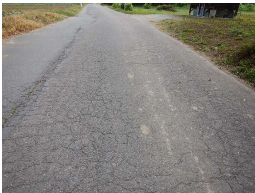
写真 1 MCI 3.0 以下の例 (市道 S-557 号)
