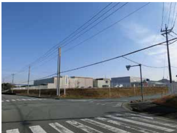
南西方向から
