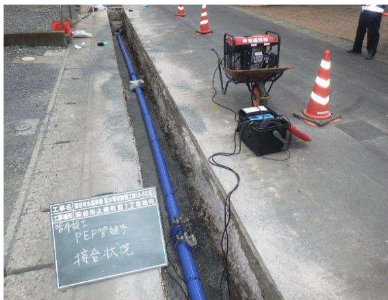
配水管工事 施工状況写真（配水用ポリエチレン管による布設替工事）
