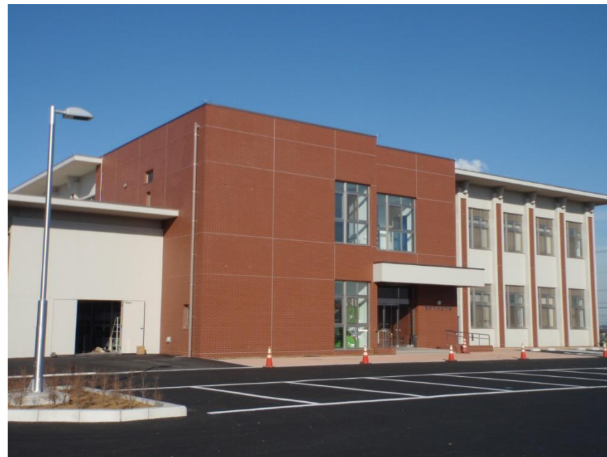
写真：水道庁舎
