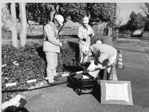
▼職員による点検の様子
