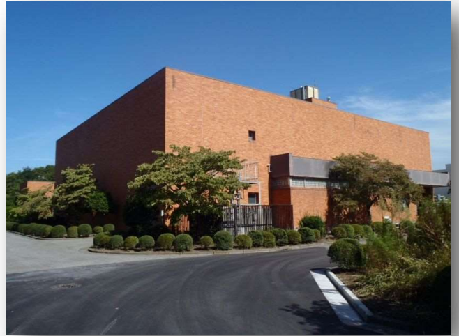
○沈砂池ポンプ棟
