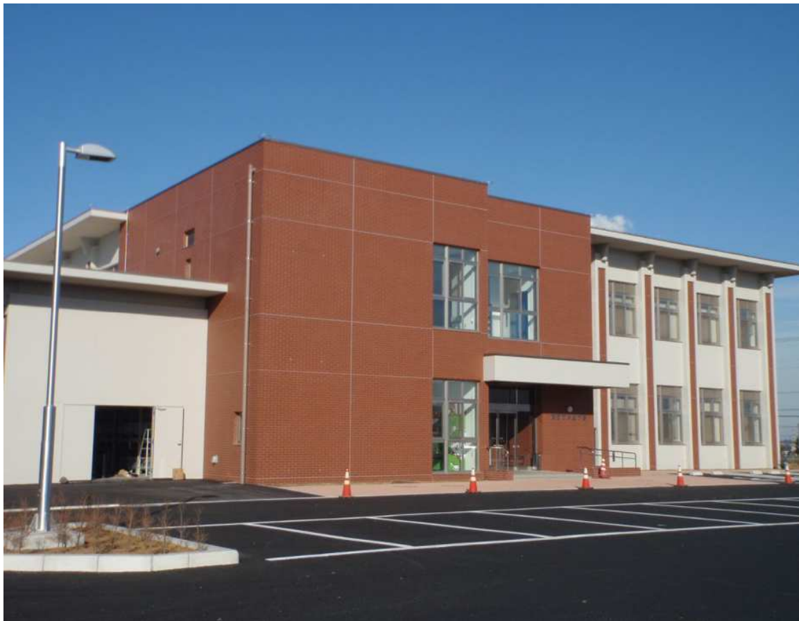
深谷市水道庁舎
