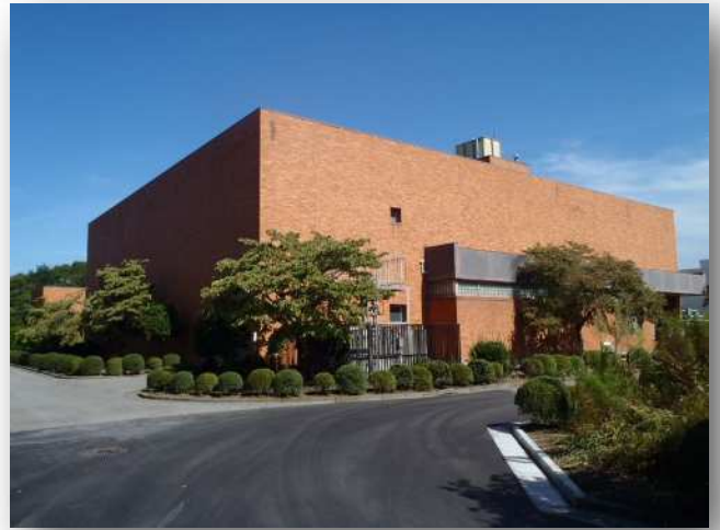
○沈砂池ポンプ棟
