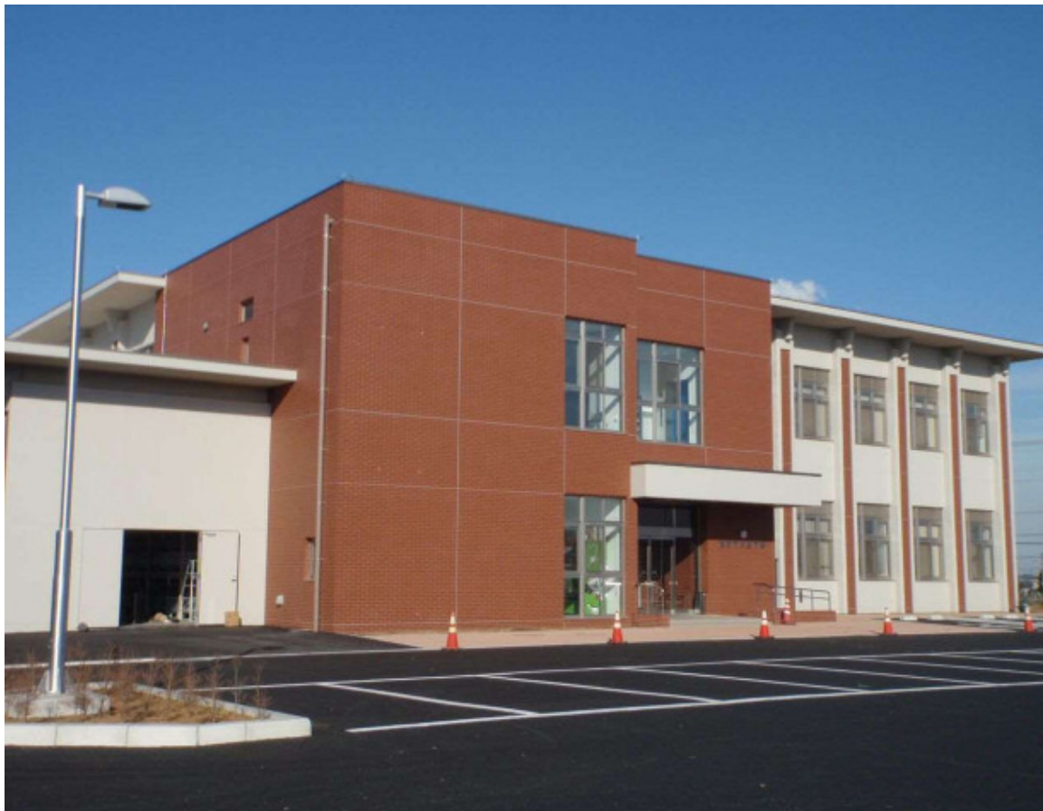
深谷市水道庁舎
