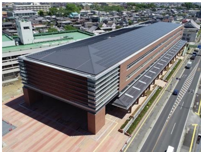
深谷市役所 本庁舎 太陽光パネル設置屋根
