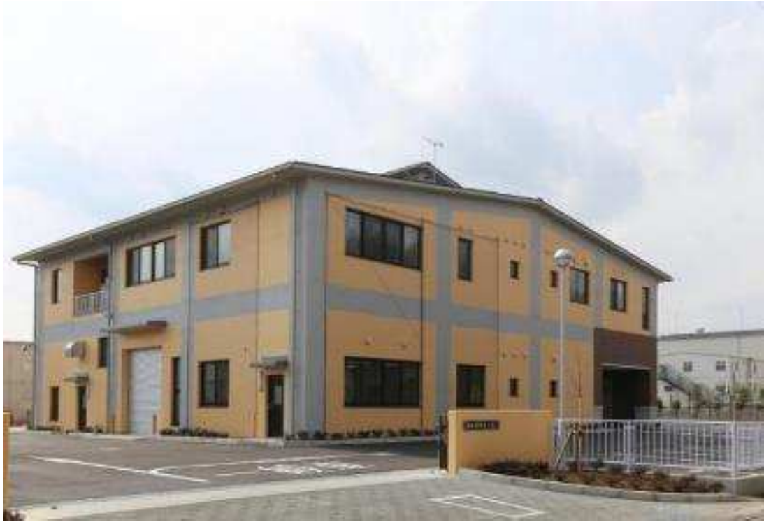
深谷市衛生センター(平成28年4月供用開始)
