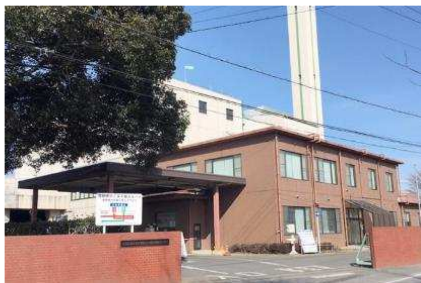
深谷清掃センター
