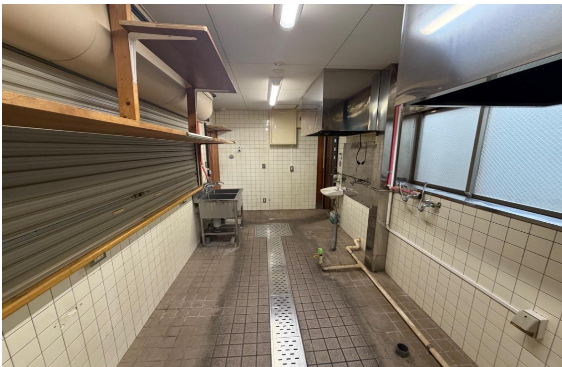
テナント内部 南→北
