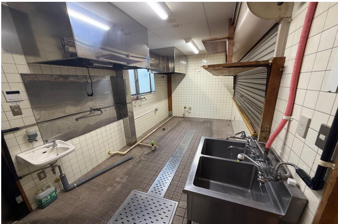
テナント内部 北→南
