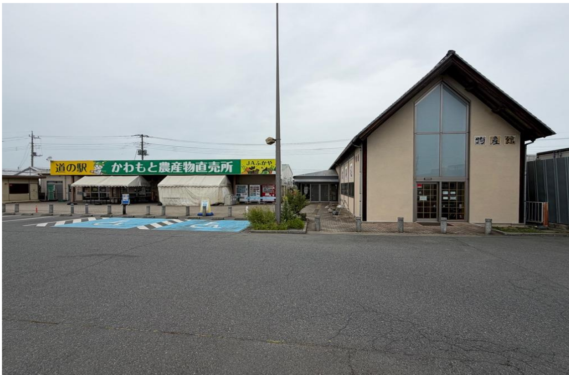
深谷市物産館 外観
