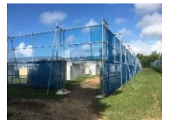
防風ネットの設置
