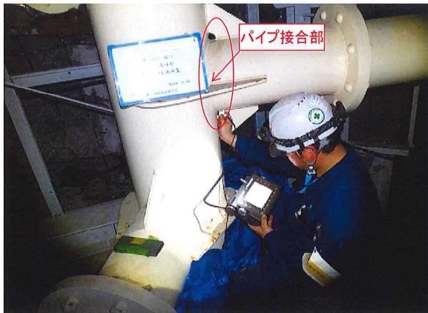
スライダー支柱円周溶接部 超音波探傷検査
