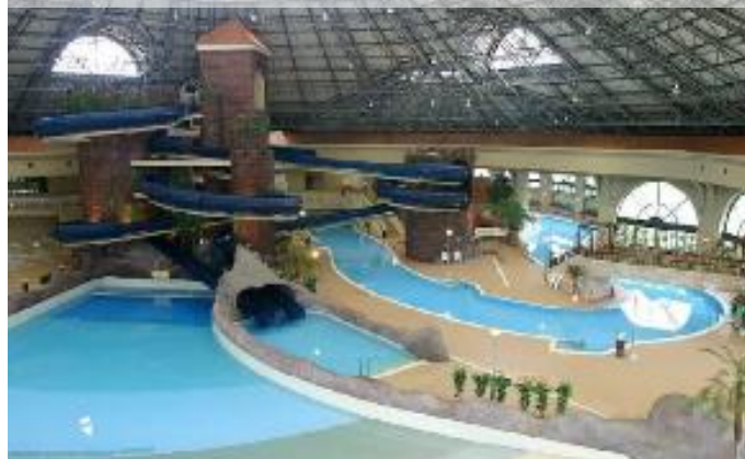
◆レジャープール(1階、全景) 約4,000㎡
