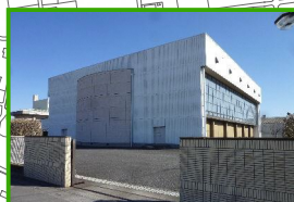
川本農業者トレーニングセンター
