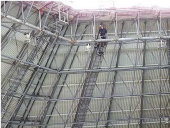
写真-8 キャットウォークからの調査状況
