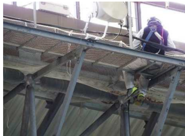
写真-7 キャットウォークからの調査状況
