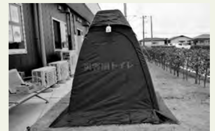
▲災害用マンホールトイレの設備
