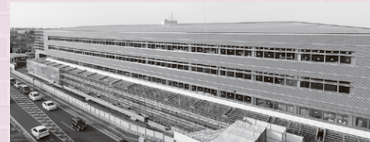
▲現在の工事の様子 (1月14日撮影) コリドー屋根工事をしています。
