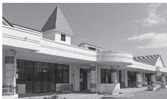
▲深谷西学童保育室(深谷西幼稚園の余裕教室を活用)
