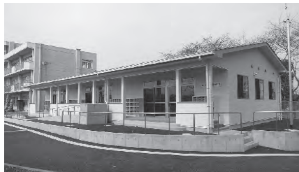
▲上柴東学童保育室(上柴東小学校敷地内に建設)
