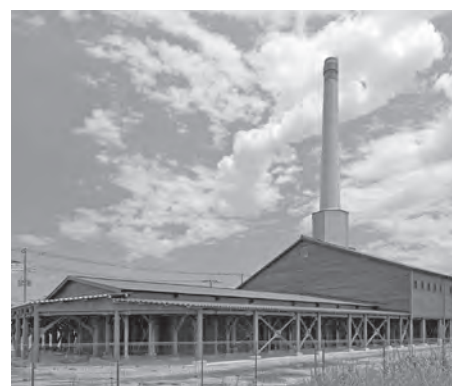
▲ホフマン輪窯6号窯の外観
