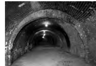
▲ホフマン輪窯6号窯内部
