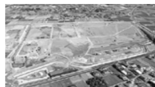
▲工事の進捗状況
