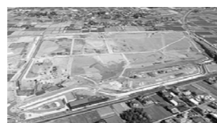
▲工事の進捗状況
