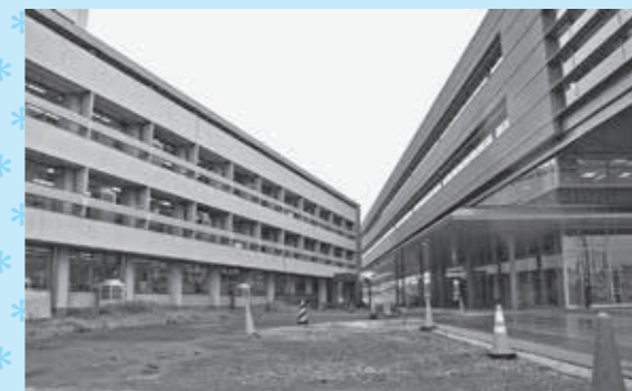
▲新庁舎と旧庁舎を一緒に撮ってみたよ。こうやって見ると2つの建物がギリギリで建てられているね～。
