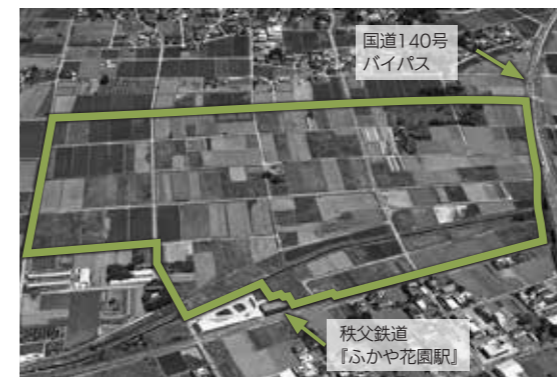
▲花園IC拠点地区の南から撮影した航空写真(2018年7月撮影)。線で囲んだ部分が花園IC拠点地区。
